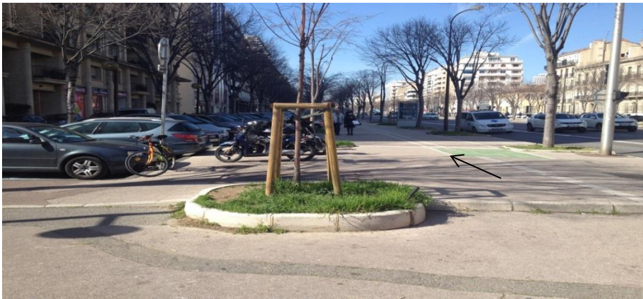
Img. 3 : Fin de la piste cyclable (en vert) ; il faut contourner l'îlot pour poursuivre son chemin car une bordure se situe au milieu du terre-plein (flèche).
