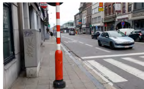
Figure 3 : poteau au milieu du trottoir
