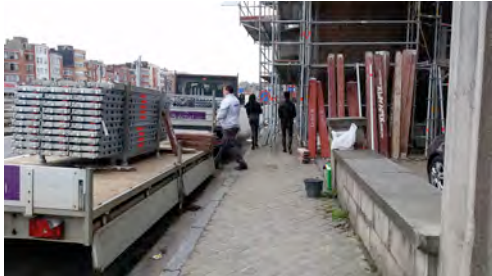
Figure 6 : échafaudage sur le trottoir
