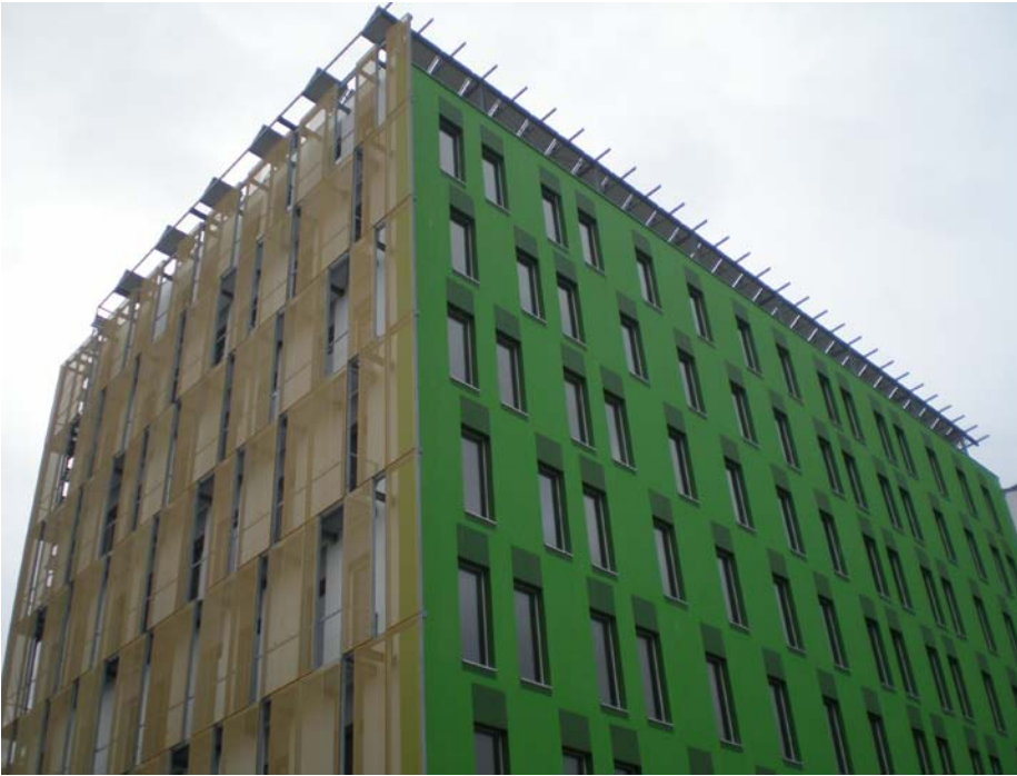
Photo 5 et 6. Les bâtiments antibruit qui longent l'autoroute (photographies personnelles)
