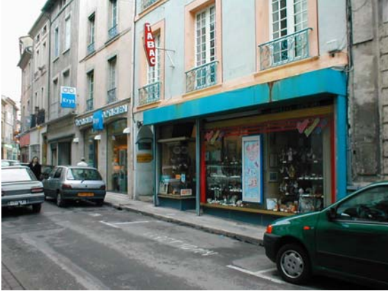
Annexe 1 : Les trottoirs avant le réaménagement
